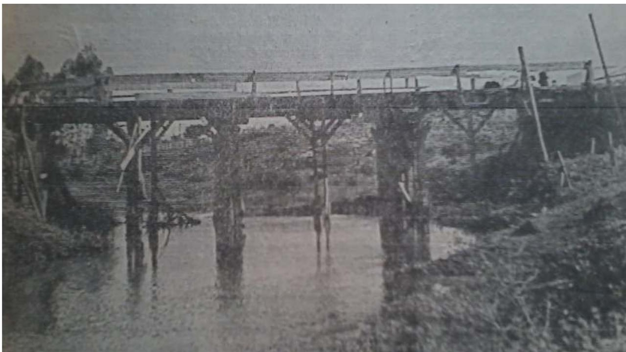
Eis a ponte demolida, que era de madeira de eucaliptos.
