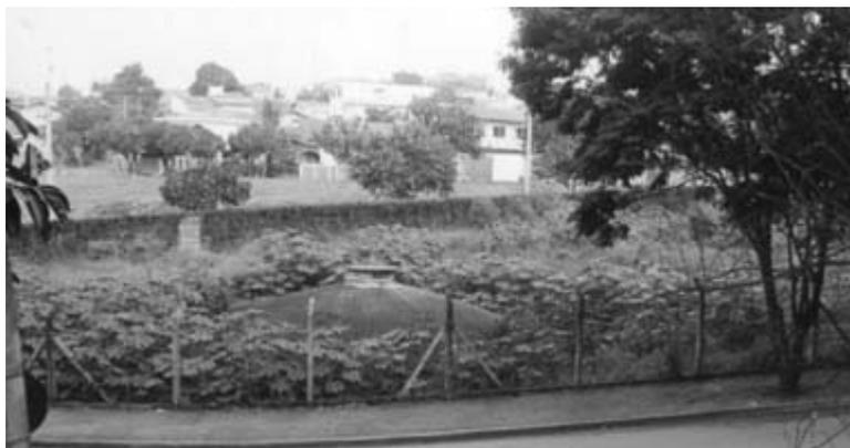
\* Construção de “Fossa Séptica – OMS”, para transformar em **adubo** a sujeira fedorenta da cidade, através do processo de **fermentação e filtragem**, localizada na **Rua Riachuelo**, proximidades do “**Ribeirão dos Toledos**” e da empresa “**Romi**”, em área central. Assim, o **esgoto** da cidade começava a ser **tratado**.
